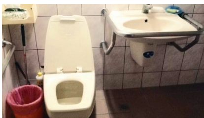
廁所備有扶手、及地面有防滑處理
